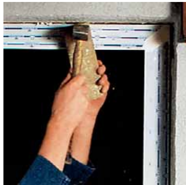
Neuen Türblendrahmen einpassen
